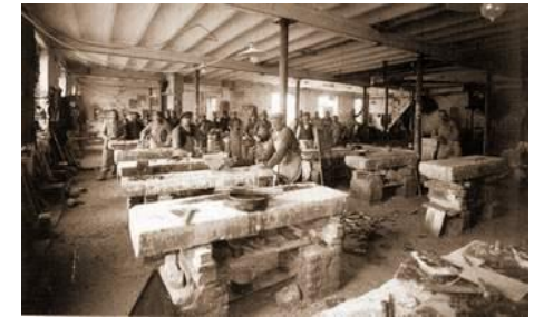
Photo 19 : Le polissage du marbre
